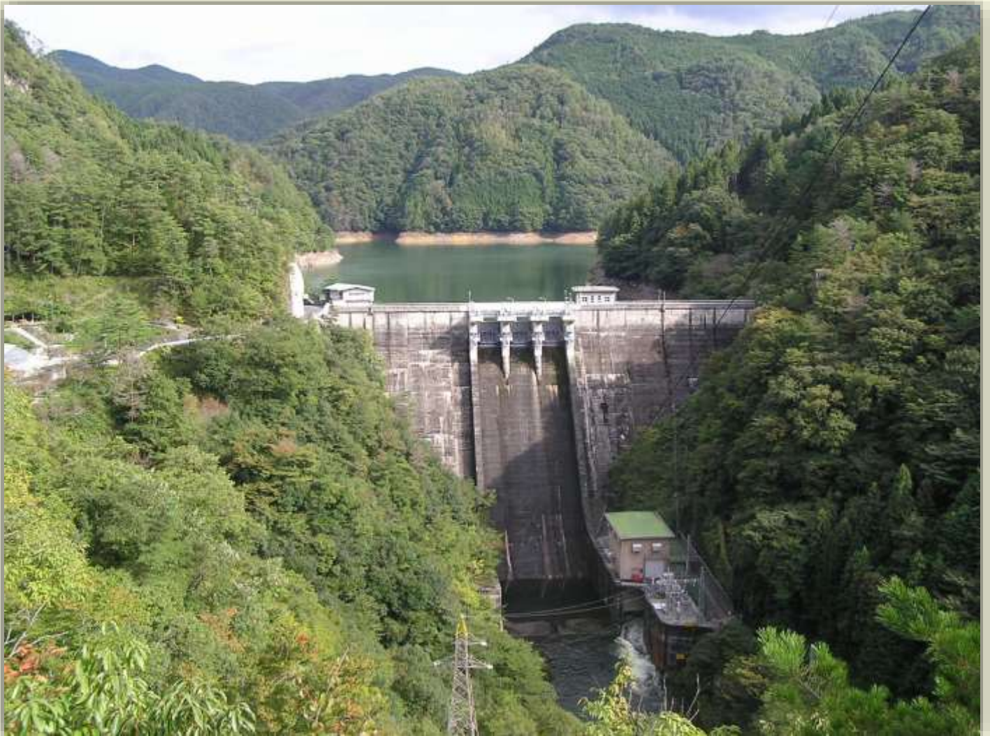
小阪部川ダム（昭和 30 年竣工）新見市
