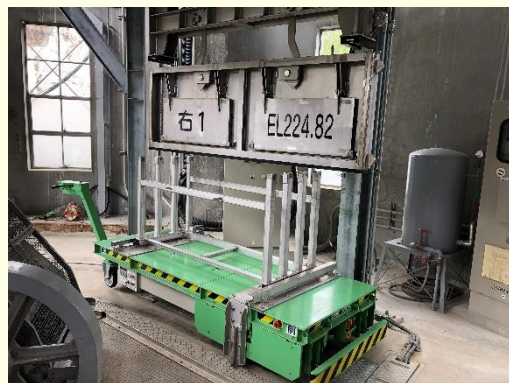
完成した表面取水ゲート（角落し）
