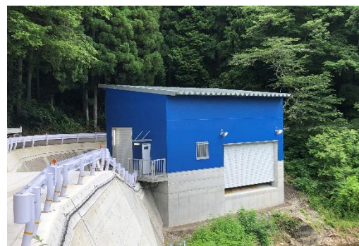
工事中のダム係船設備（インクライン）
