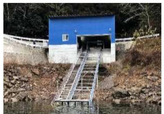
完成したダム係船設備（インクライン）
