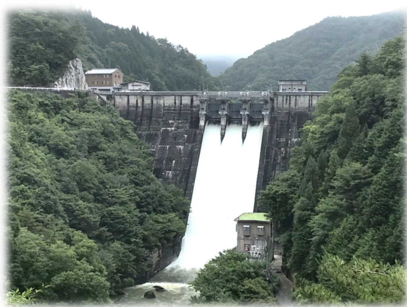
洪水吐ゲートから放流中の小阪部川ダム
