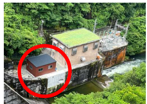
完成した放流設備（利水放流ゲート）
