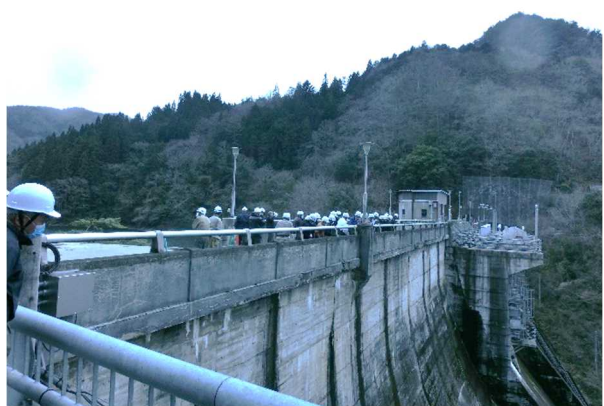
堤体上で洪水吐ゲートの説明
