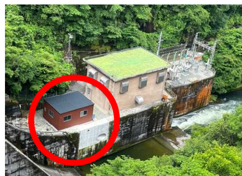
完成した放流設備（利水放流ゲート）
