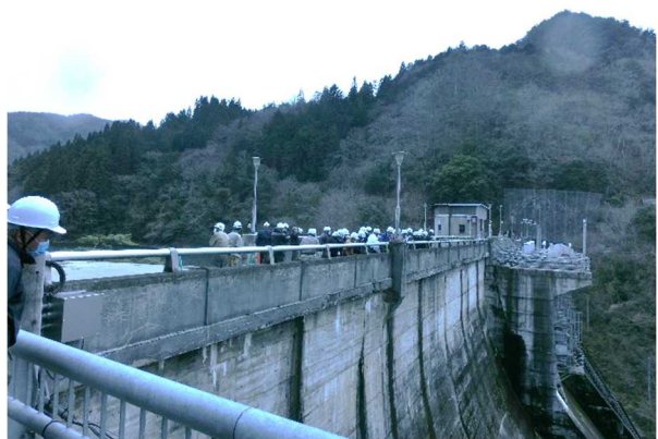
堤体上で洪水吐ゲートの説明
