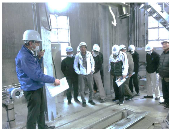
取水塔内で角落しの説明
